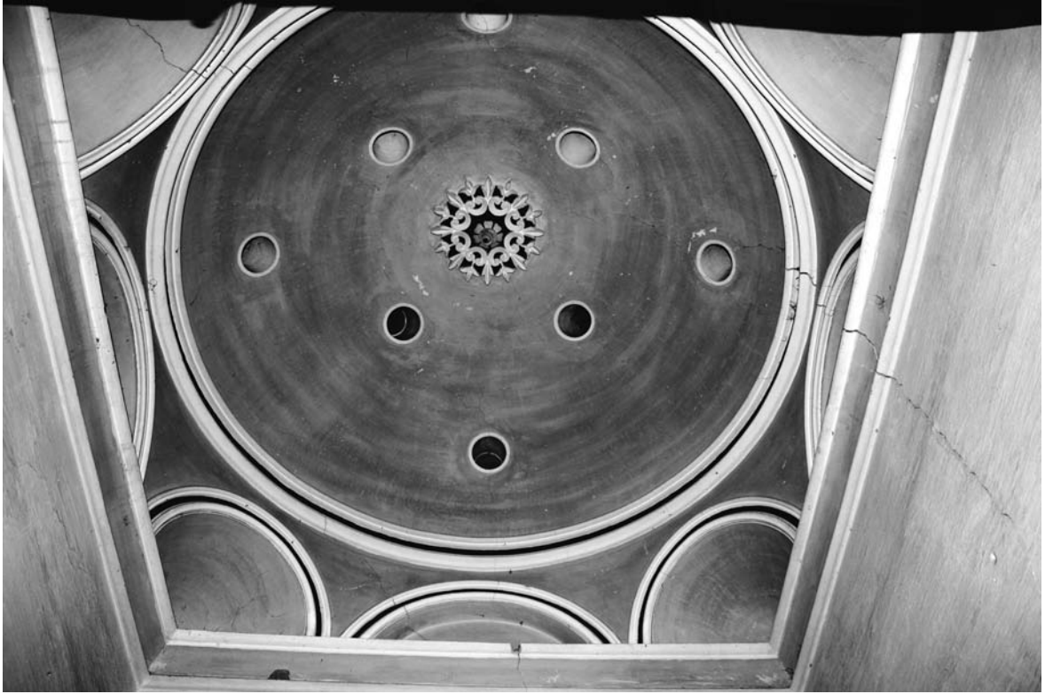
لوحة (٨). بيت الكاتب: الطابق الأول، حمام السلامك، الحجرة الساخنة، القبة التي تغطي الحجرة ومنطقة إنتقالها.
